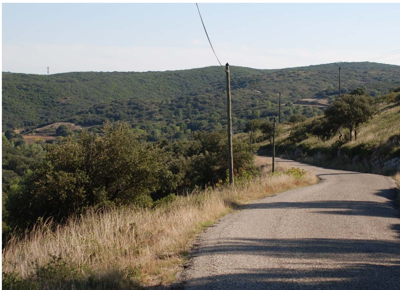
Route D418 dans la combe du Pontel
